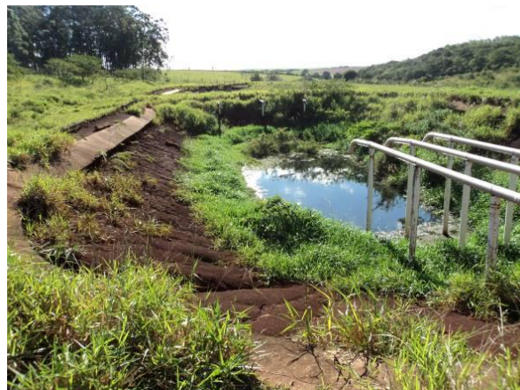
Figura 04. Vista da primeira lagoa de tratamento do Distrito de Santo Antonio do Paranapanema
