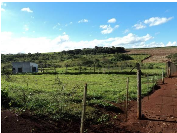
Figura 03. Vista da fachada da lagoa de tratamento do Distrito de Santo Antonio do Paranapanema
