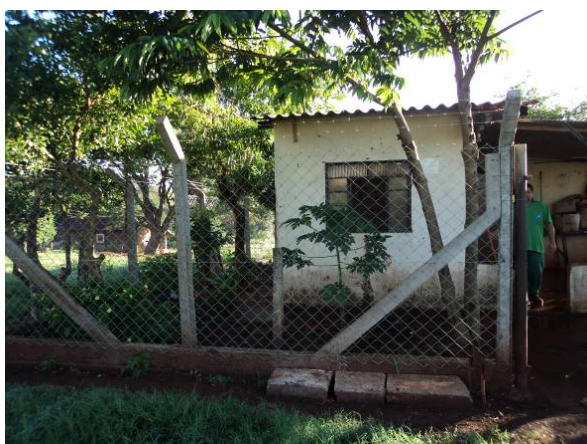
Figura 148. Vista fachada da Estação Elevatória Escola Agrícola
