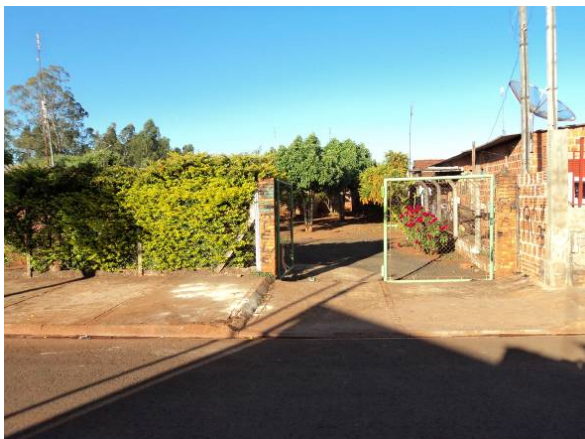
Figura 152. Vista da fachada da Estação Elevatória Jardim Alvorada
