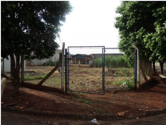
Figura 100. Vista do Poço- P15
