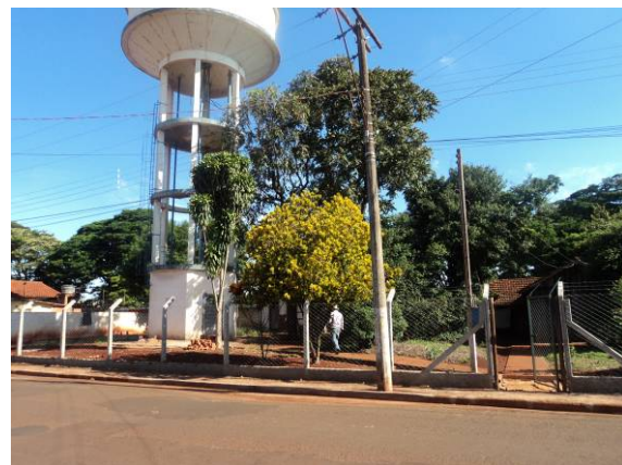
Figura 58. Vista do Reservatório R04
