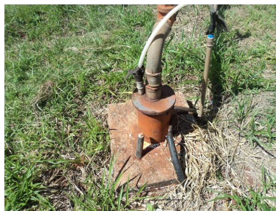
Figura 67. Vista do Poço- P07
