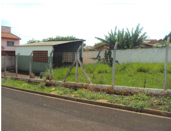
Figura 160 Vista da EEE do Santo Antonio do Paranapanema
