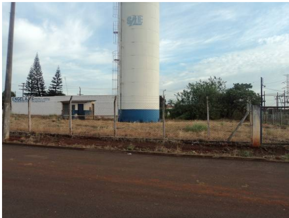
Figura 96. Vista do Reservatório - R10
