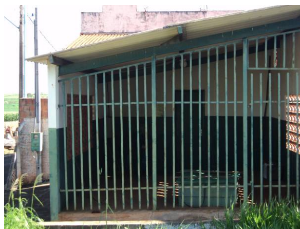
Figura 161. Casa de bombas da EEE do Santo Antonio do Paranapanema
