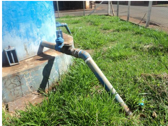
Figura 46. Vista da entrada do Reservatório R03
