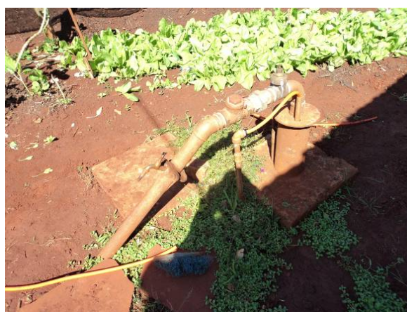
Figura 117. Vista do Poço- P19 do Distrito de Frutal do Campo
