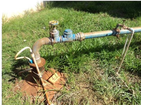
Figura 44. Vista do Poço- P03
