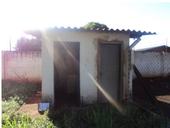
Figura 63. Vista do Abrigo do Painel Elétrico
