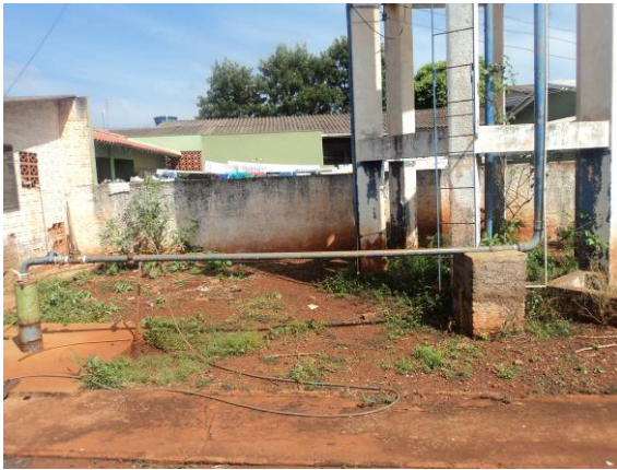
Figura 106. Vista do Poço- P17
