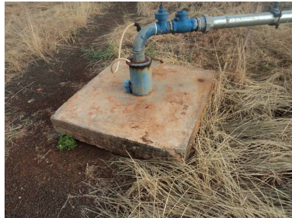
Figura 95. Vista do Poço- P14
