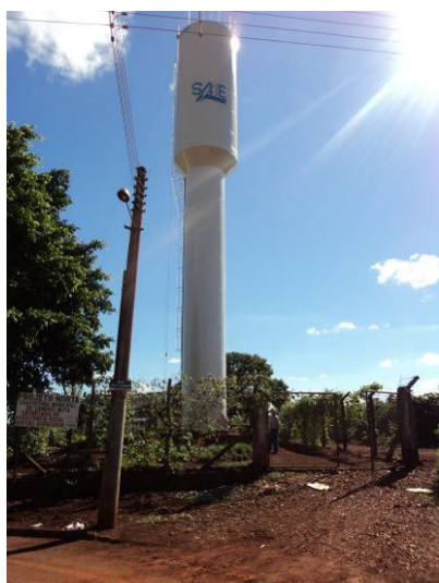
Figura 118. Vista do Reservatório R15 do Distrito de Frutal do Campo
