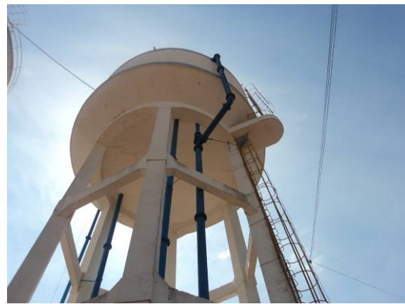
Figura 38. Vista do Reservatório R01
