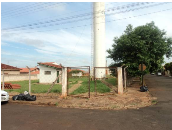
Figura 84. Vista do Reservatório R06
