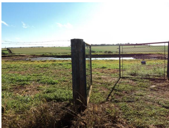
Figura 164. Vista da fachada da lagoa de tratamento do Distrito de Nova Alexandria
