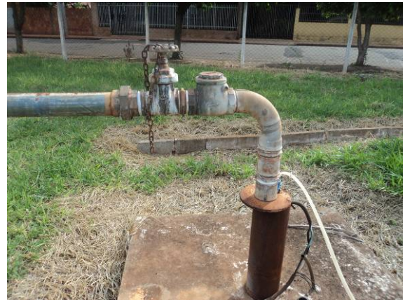
Figura 83. Vista do Poço- P12
