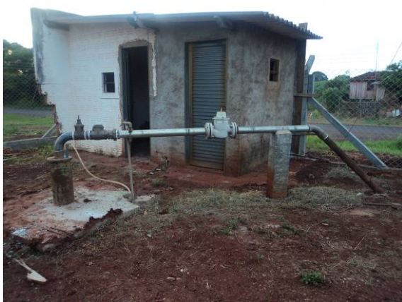
Figura 49. Vista do Poço- P04
