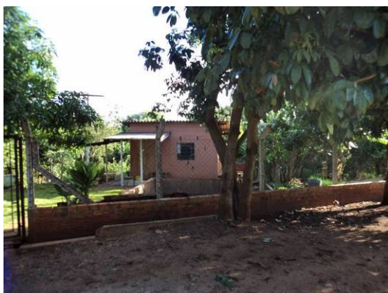
Figura 144. Vista fachada da entrada Estação elevatória Santa Terezinha
