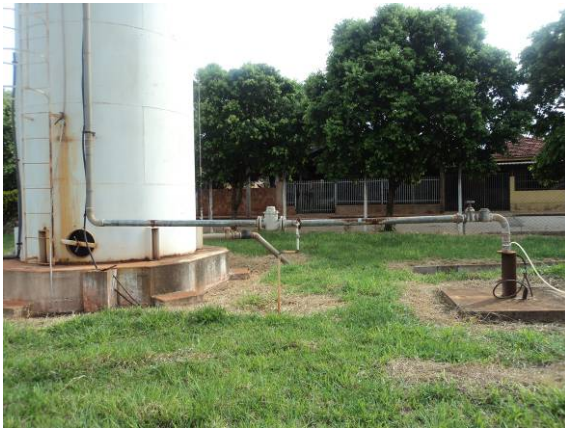
Figura 82. Vista do Poço- P12
