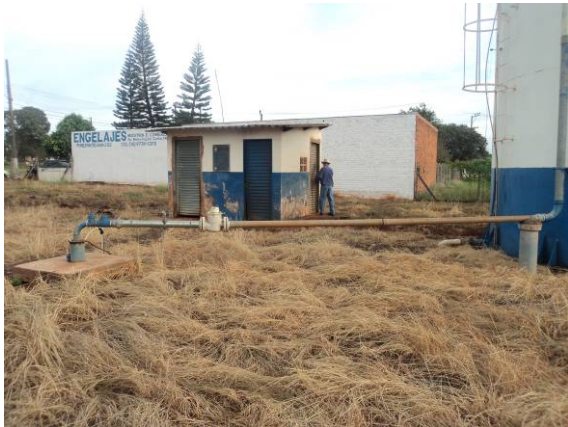
Figura 94. Vista do Poço- P14
