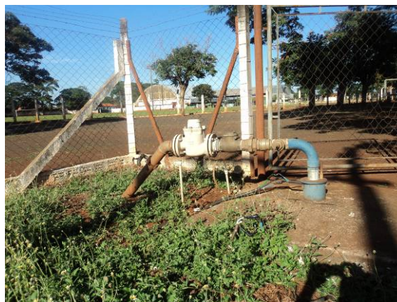
Figura 62. Vista do Poço- P06
