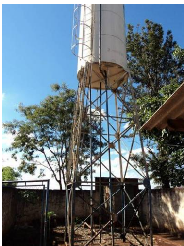
Figura 126. Vista do Reservatório – R17
