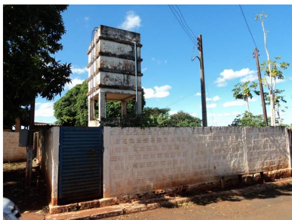
Figura 120. Vista do local do Poço- P20
