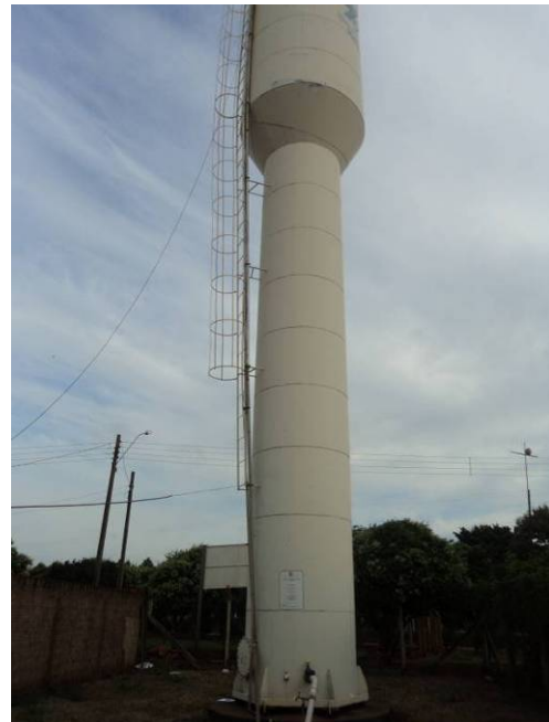
Figura 103. Vista do Reservatório - R11
