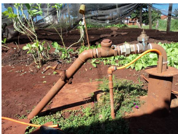
Figura 116. Vista do Poço- P19 do Distrito de Frutal do Campo
