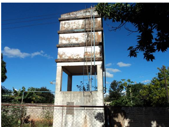
Figura 122. Vista do Reservatório – R16
