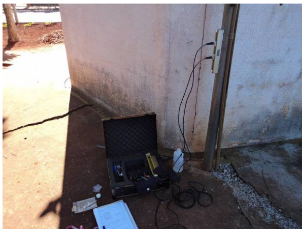
Figura 131. Medição de vazão com medidor ultrassônico no Poço P06
