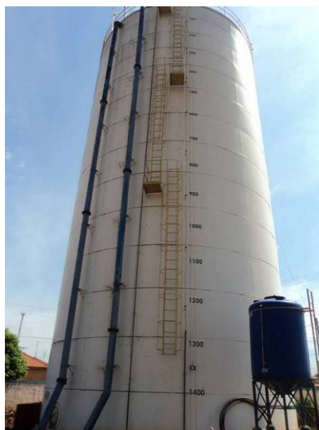
Figura 39. Vista do Reservatório R02
