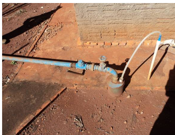
Figura 125. Vista do Poço- P21
