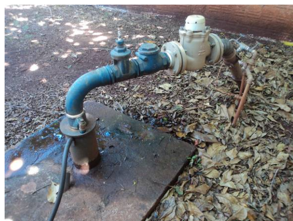
Figura 79. Vista do Poço- P10
