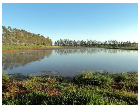
Figura 141. Vista da lagoa da ETE da sede do município
