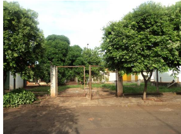
Figura 91. Vista do portão de acesso do Reservatório R09
