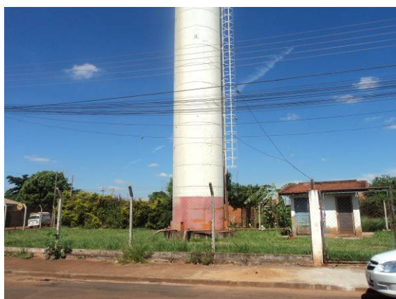
Figura 68. Vista do Reservatório R05
