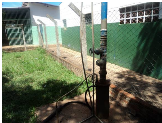
Figura 75. Vista do Poço- P09
