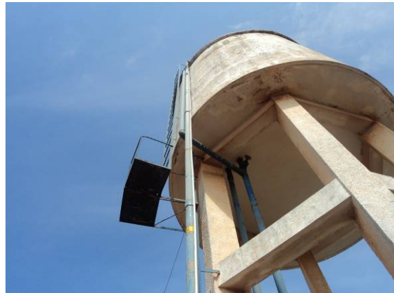
Figura 109. Vista do Reservatório- R13
