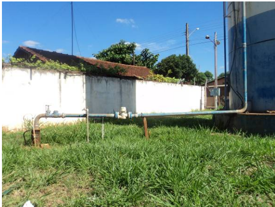
Figura 43. Vista do Poço- P03
