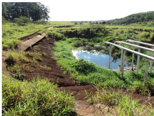
Figura 157. Vista da primeira lagoa de tratamento do Distrito de Santo Antonio do Paranapanema
