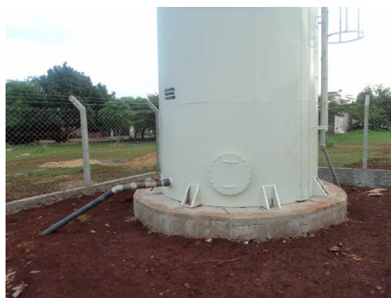
Figura 52. Vista do Reservatório que está sendo implantado.
