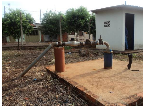
Figura 101. Vista do Poço- P15
