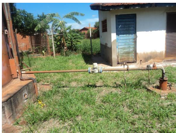
Figura 66. Vista do Poço- P07
