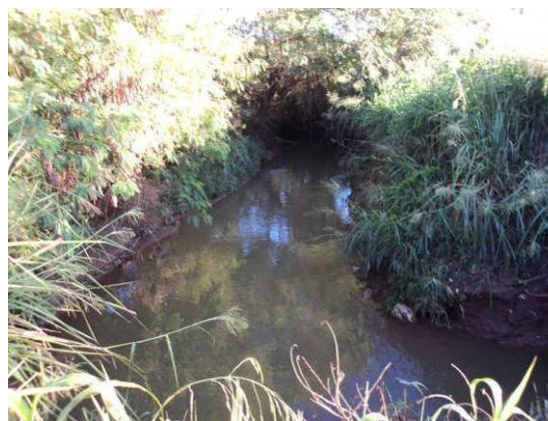
Figura 143. Vista do ponto de lançamento do efluente tratada no córrego Água do Jacu
