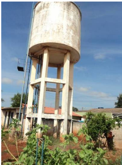
Figura 108. Vista do Reservatório- R13
