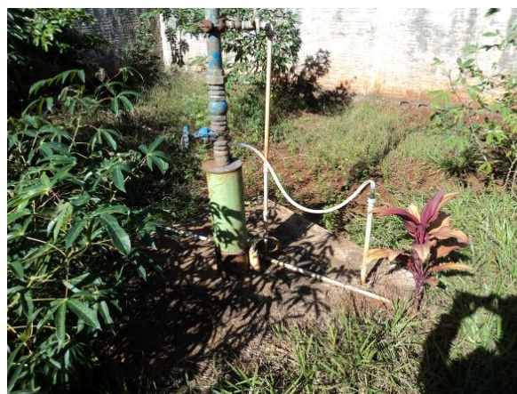
Figura 121. Vista do Poço- P20
