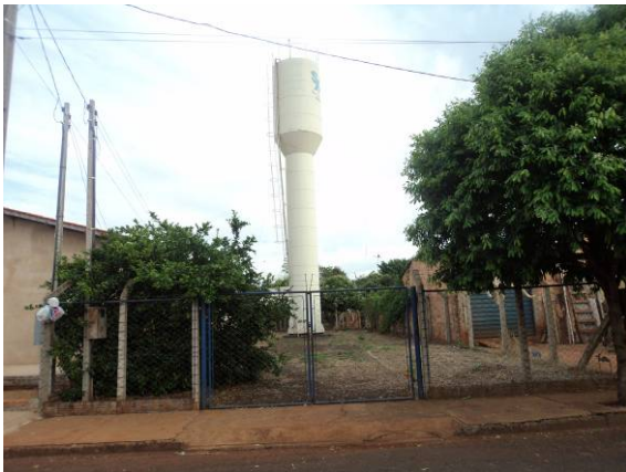
Figura 102. Vista do Reservatório - R11
