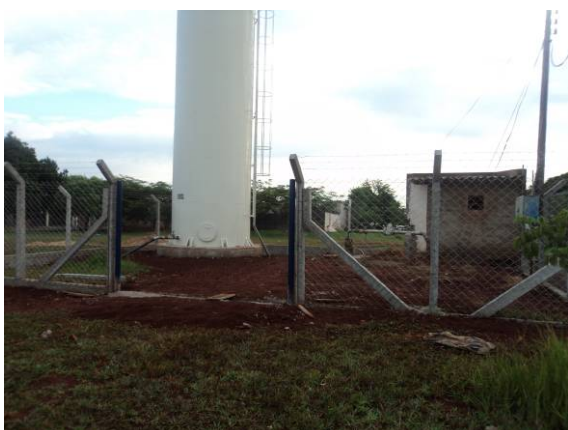
Figura 51. Vista do Reservatório que está sendo implantado.
