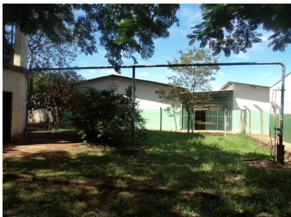
Figura 74. Vista do Poço- P09
