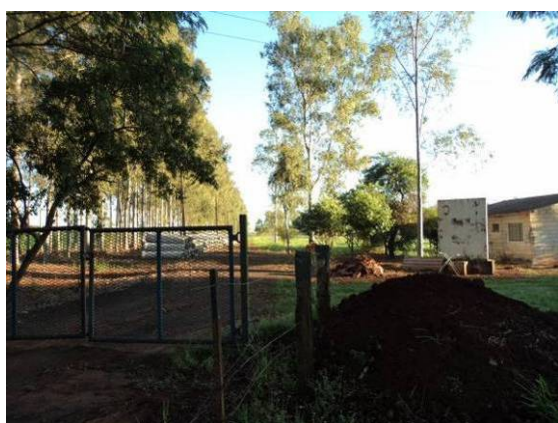
Figura 140. Vista da fachada da entrada da ETE
