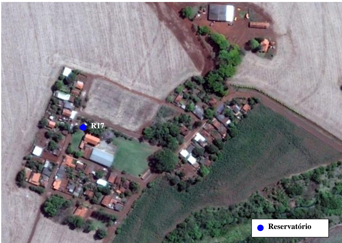
Figura 33. Localização do reservatório existente no município de Cândido Mota (Patrimônio São Benedito)
