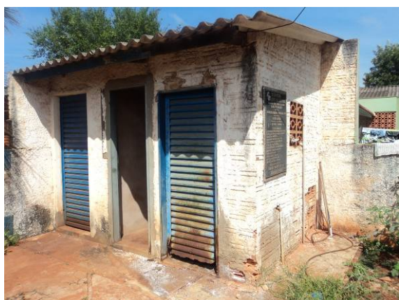
Figura 110. Vista do Abrigo do Painel elétrico
