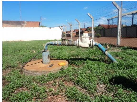
Figura 71. Vista do Poço- P08
