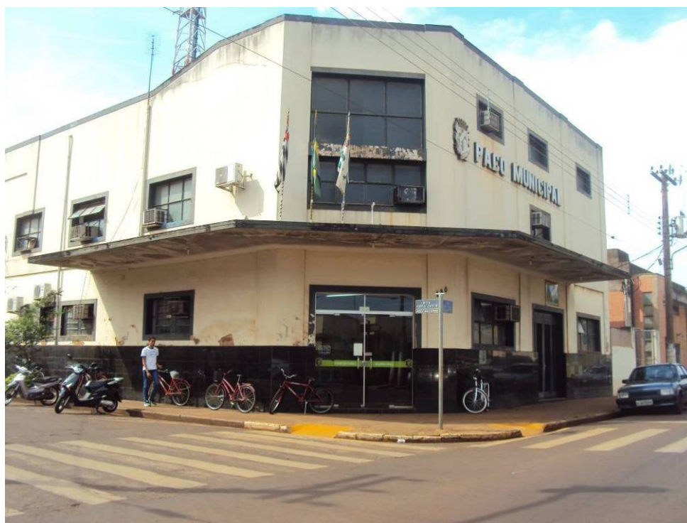
Figura 21. Vista da fachada do Paço Municipal de Cândido Mota
