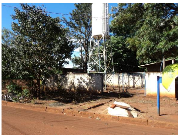
Figura 124. Vista do Poço- P21
