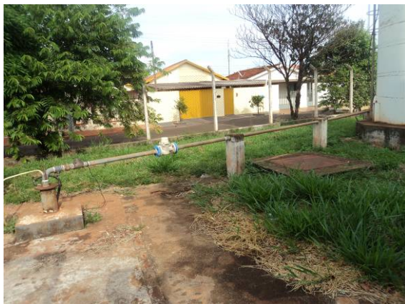
Figura 88. Vista do Poço- P13
