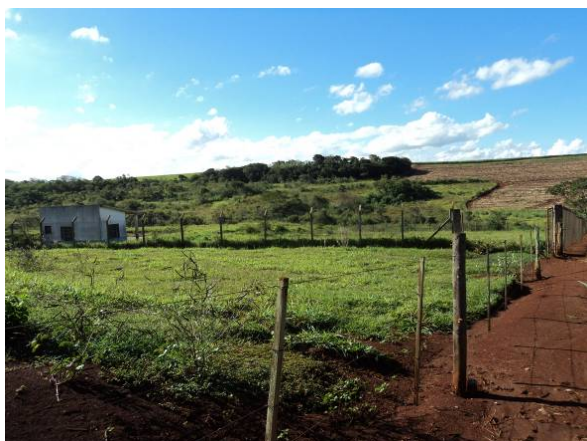
Figura 156. Vista da fachada da lagoa de tratamento do Distrito de Santo Antonio do Paranapanema
