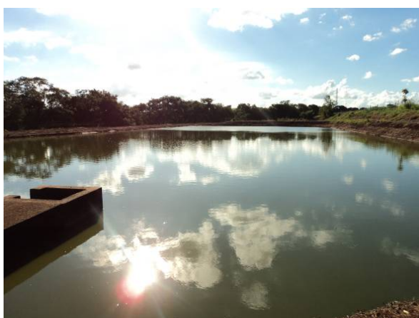
Figura 170 Vista da lagoa de tratamento de esgoto do Distrito de Frutal do Campo
