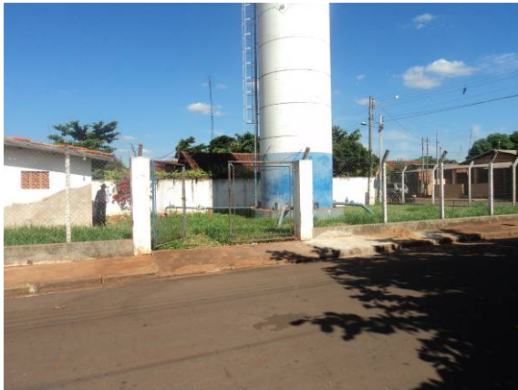
Figura 45. Vista do Reservatório R03
