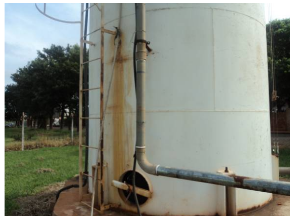
Figura 85. Vista do Reservatório R08
