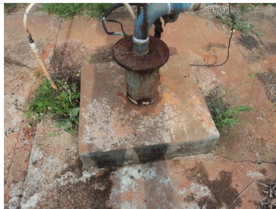
Figura 89. Vista do Poço- P13
