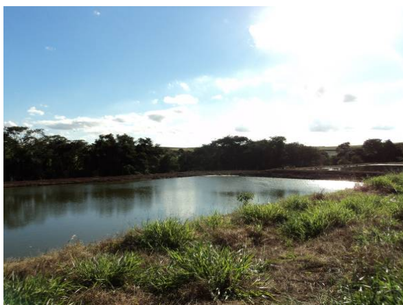
Figura 168. Vista da lagoa de tratamento de esgoto do Distrito de Frutal do Campo
