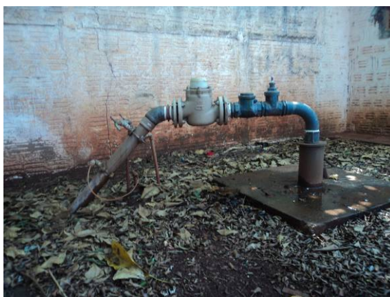
Figura 78. Vista do Poço- P10
