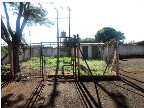
Figura 61. Vista do Poço- P06
