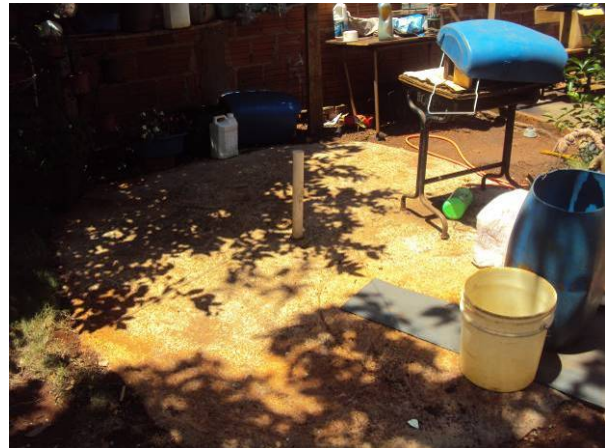
Figura 134. Vista de um sumidouro residencial no Patrimônio de São Benedito
