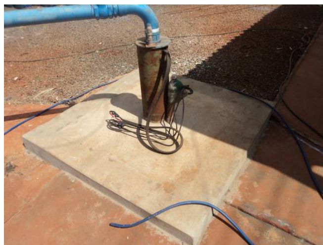
Figura 40. Vista do Poço- P02
