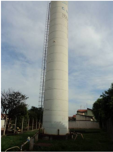
Figura 90. Vista do Reservatório R09
