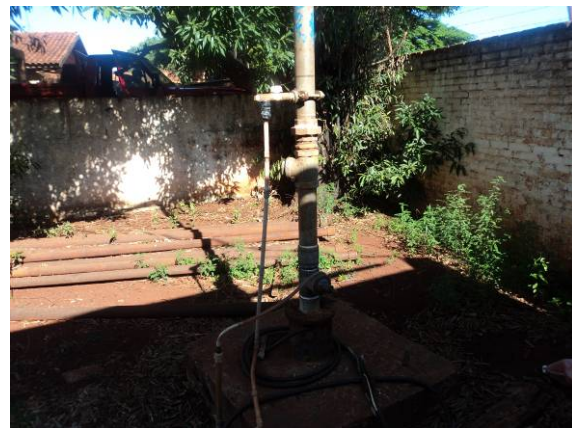
Figura 56. Vista do Poço- P05
