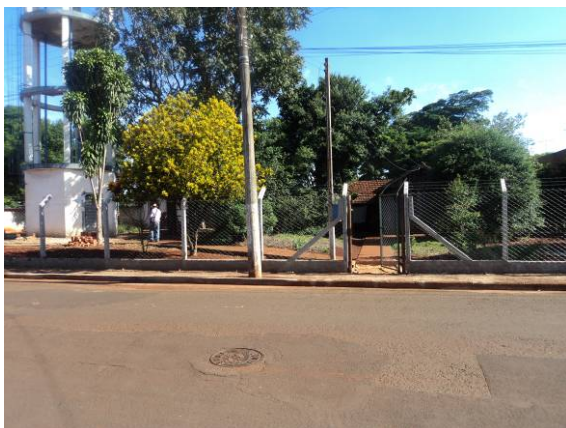
Figura 57. Vista do acesso do Reservatório R04
