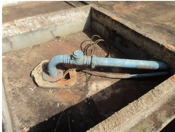
Figura 36. Vista do Poço P1
