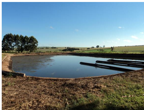
Figura 165. Vista da lagoa de tratamento do Distrito de Nova Alexandria
