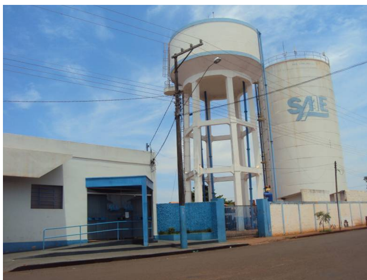
Figura 22. Vista da fachada da sede do SAAE de Cândido Mota
