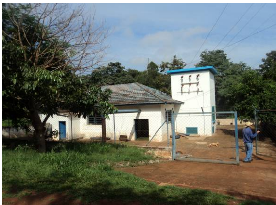
Figura 34. Vista da Estação Elevatória
