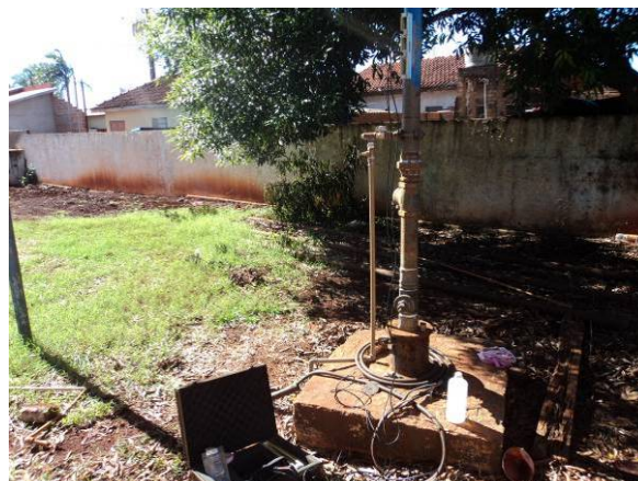
Figura 130. Medição de vazão com medidor ultrassônico no Poço P05
