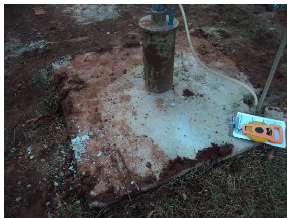
Figura 50. Vista do Poço- P04
