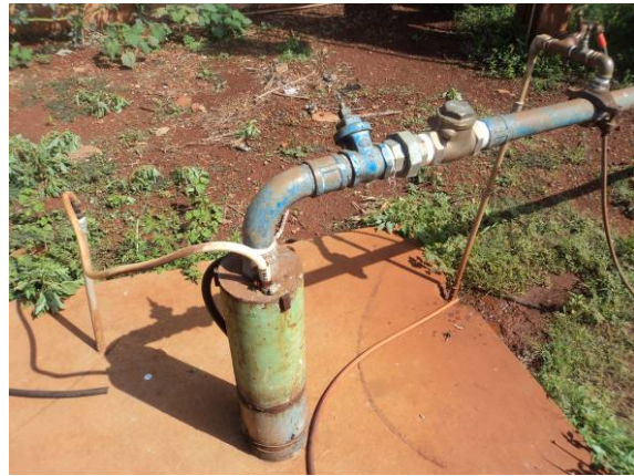
Figura 107. Vista do Poço- P17
