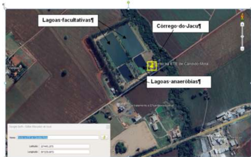
Figura 1 -- Localização da Estação de Tratamento de Efluentes (ETE)
